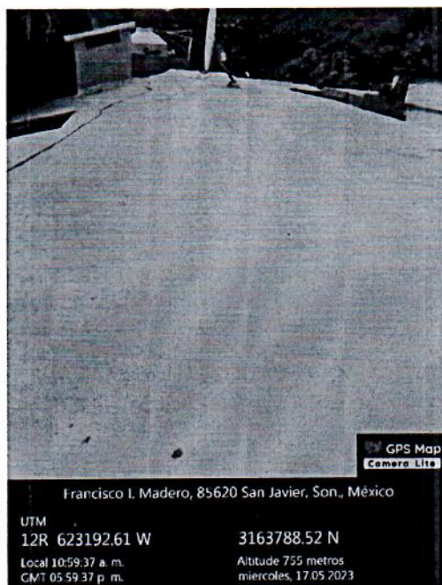
CONCEPTO ACA-011: Impermeabilización en azotea con material elastómero en color blanco
